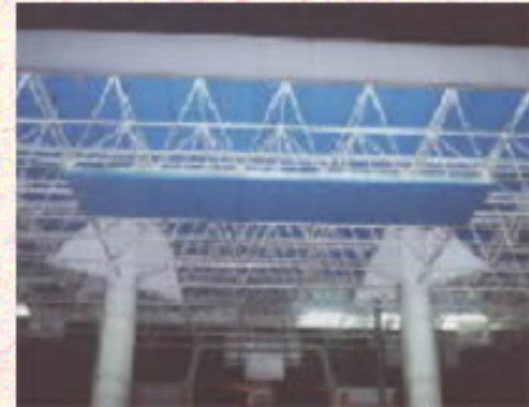
パイプ ラス 構造の 屋根への取付け
